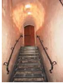
شكل(34): يوضح استخدام درج حديدي لإظهار الدرج القديم المصدر: الباحث
