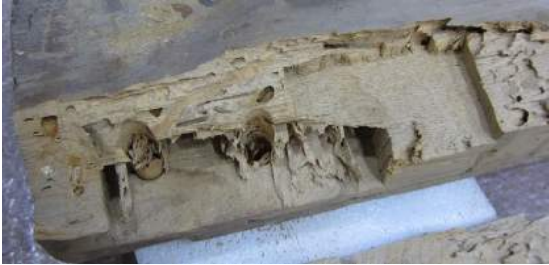
الصورة (١١) توضح التهشم الحاصل في الباب نتيجة الضرر الذي لحق به
