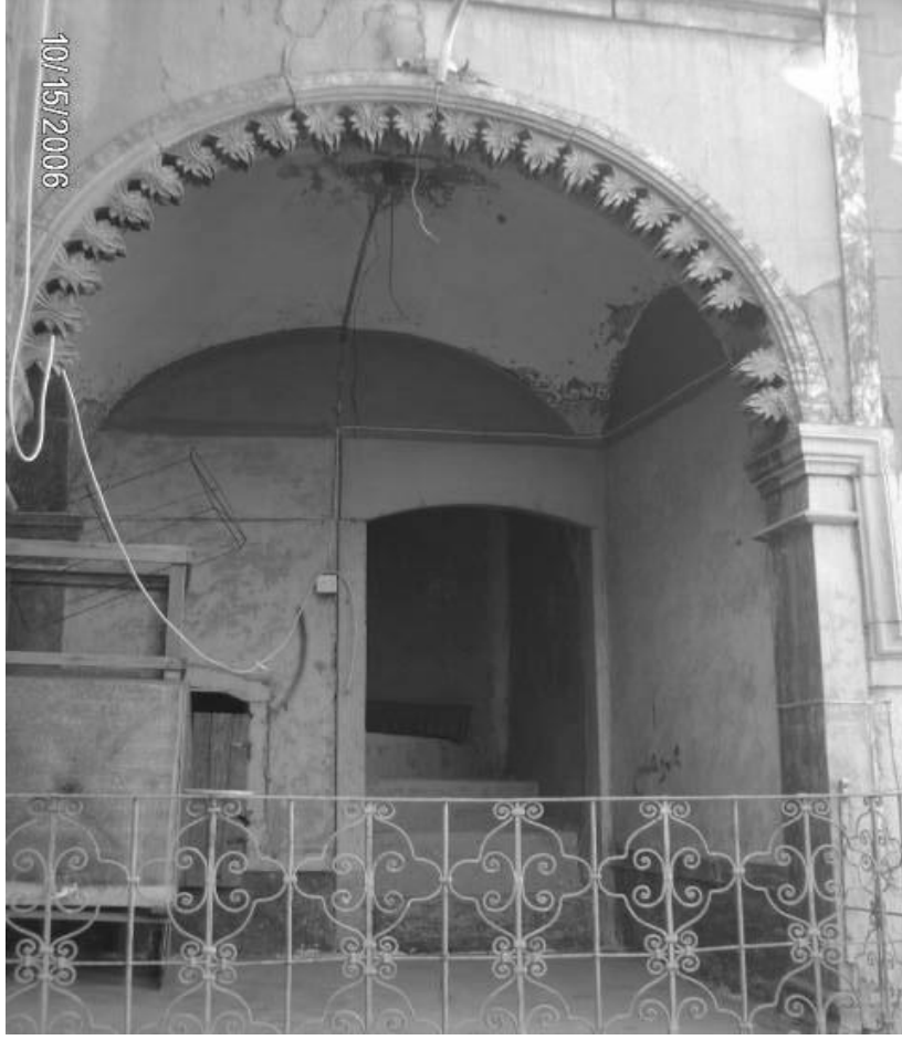
الصورة (٦) الفسحة التي في الطابق الثاني
