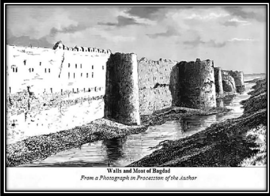
شكل رقم (٨) بقايا السور جانب الباب الشرقي نقلاً عن: صور بغداد القديمة (الشبكة العنكبوتية)
