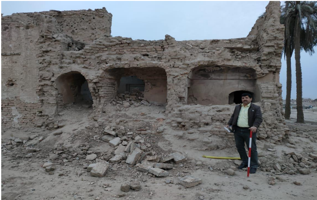
لوح (٤٣) اجزاء مهدامة من المرافق الخدمة في القسم الجنوبي (تصوير الباحث)
