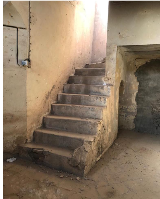
لوح (٣٩) سلم القسم الجنوبي للدار (تصوير الباحث)
