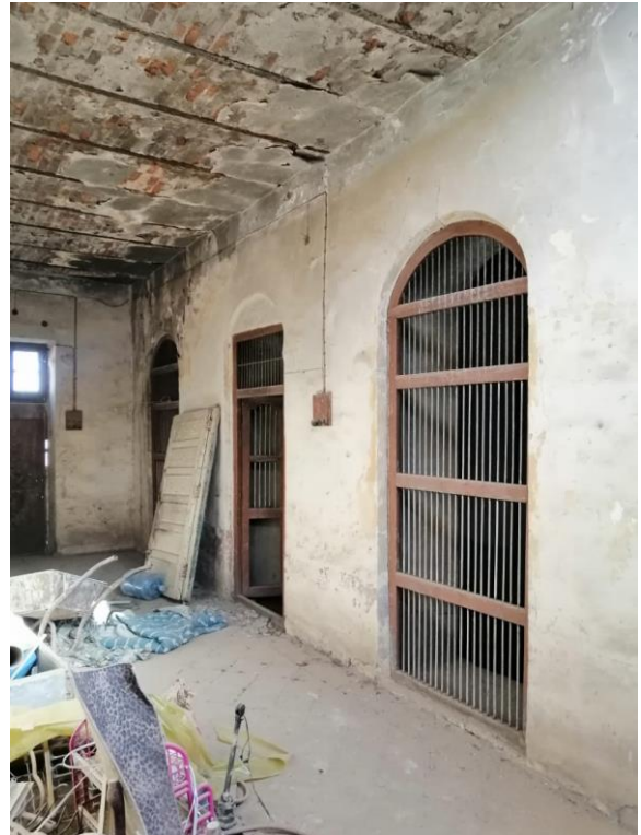
لوح (٢٩) مدخل السرداب وبابه ونوافذ وشبابيكه التي تقابل الحوة الضيوف الخاصة بالنساء (تصوير الباحث)
