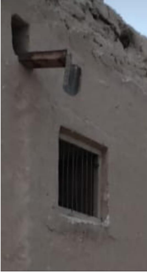
لوح (٤٢) نافذة وشباك المطبخ (تصوير الباحث)
