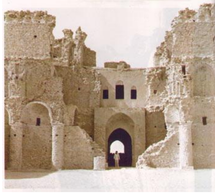
الشكل (٤) تأثير الأمطار على تآكل المونة (حصن الأخيضر)
