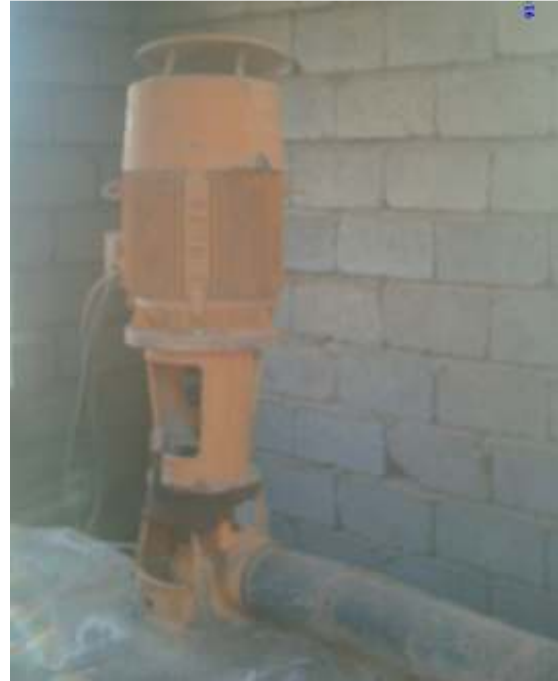
شكل ١- المضخة التوربينية منصوبة على البئر
