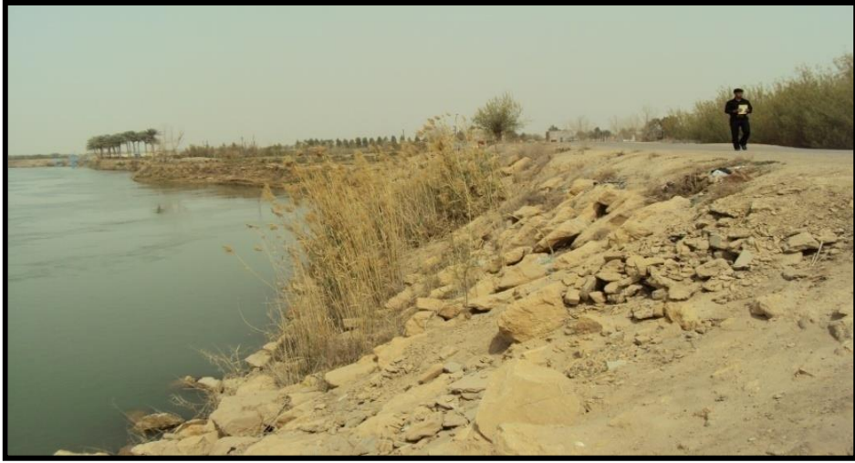
صورة (٤) رصف ضفاف النهر بالحجر لإيقاف تآكله.(التقطت من قبل الباحث بتاريخ ٢٥/٩/٢٠١٣)
