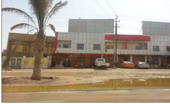
صورة (٥) عدم تناسق عرض المباني
