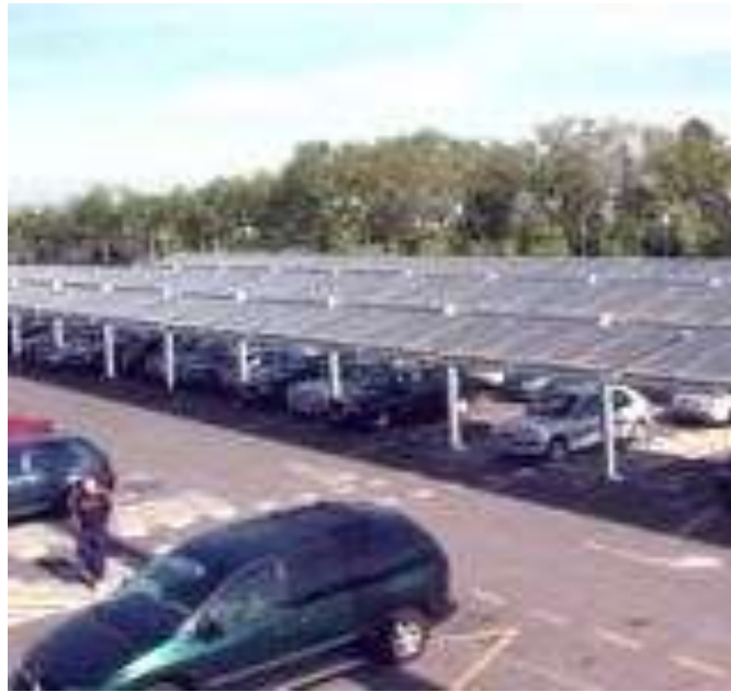
شكل رقم (17): استغلال اسطح الكراجات لنصب الخلايا الشمسية
