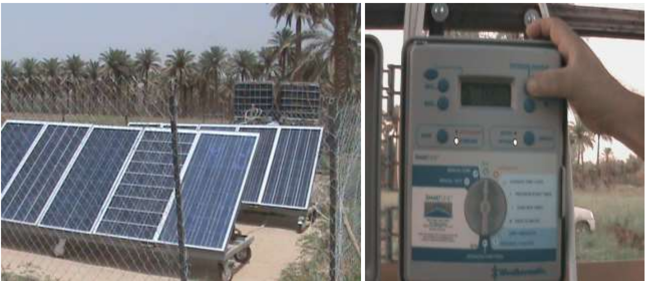
شكل (19): منظومة الخلايا الشمسية و ال (PLC) الموضحة في الشكل (18) و المستخدمة فعلياً من قبلنا في تشغيل منظومة الري بالتنقيط في موقع المشروع البحثي (قضاء المسيب – قرية اولاد مسلم)
