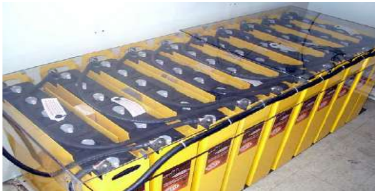
شكل (9): نموذجاً للبطاريات المستخدمة و طريقة ربطها
