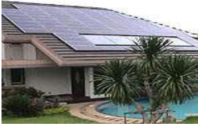
شكل (12): كيفية تركيب الخلايا الشمسية على سطح احد المنازل
