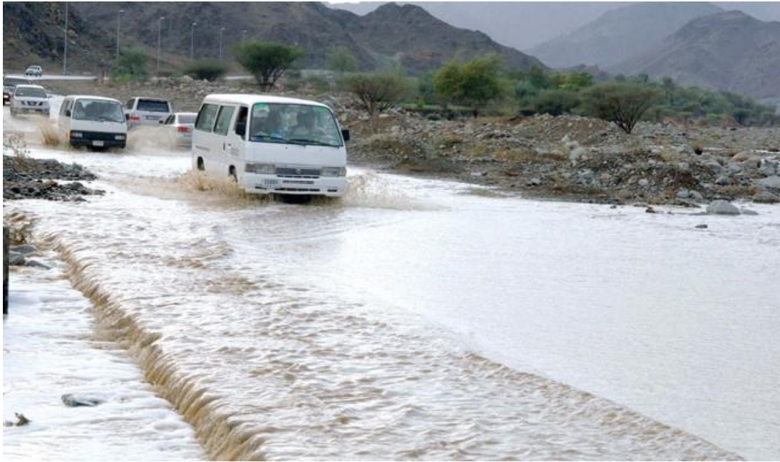
شكل 1- فشل التصميم الهيدرولوجي للطريق
