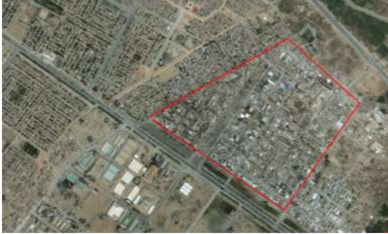
الشكل رقم (4) يوضح الصورة فضائية لمنطقة الدراسة ومجاوراتها المصدر: مديرية التخطيط العمراني، صورة فضائية التقطت بتاريخ 2013/5/17
