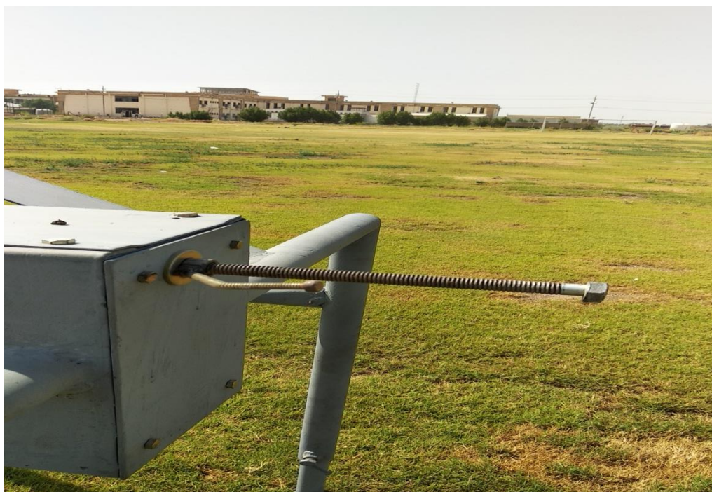
شكل (٢) يبين كيفية شد النواض عن طريق البرغي
