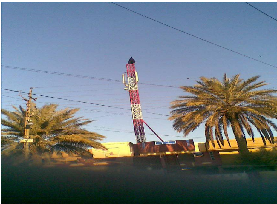
الشكل (1): صورة لبرج موضوع بصورة عشوائية فوق احد البيوت السكنية في منطقة الدورة.
