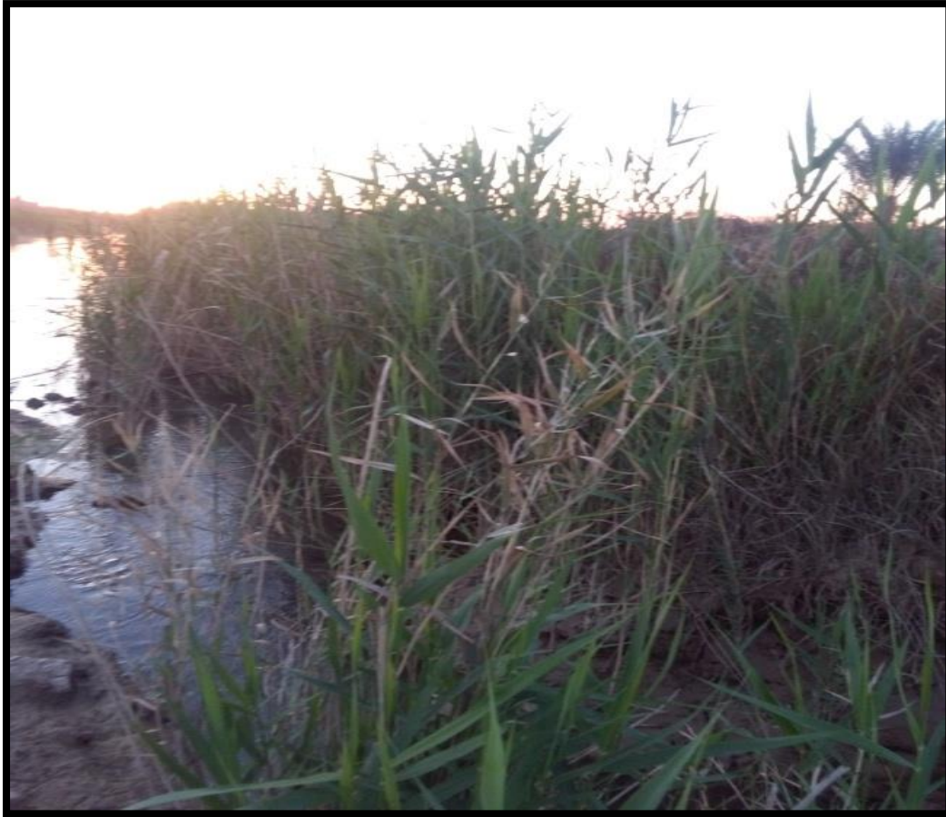
نمو نبات القصب داخل مبزل CD#C
