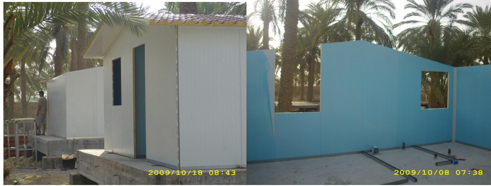
شكل رقم (٧): تركيب السندويج بنل في الجدران الداخلية والخارجية للبيوت
