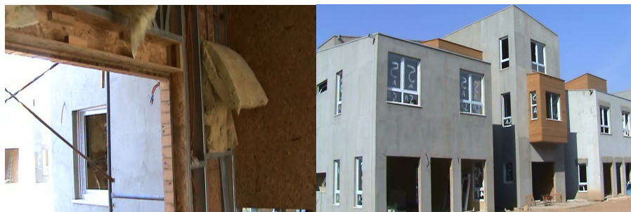
شكل رقم (٣): تركيب الطبقات الخارجية والعازلة و الشكل النهائي للبيت بعد اكتماله تقريبا
