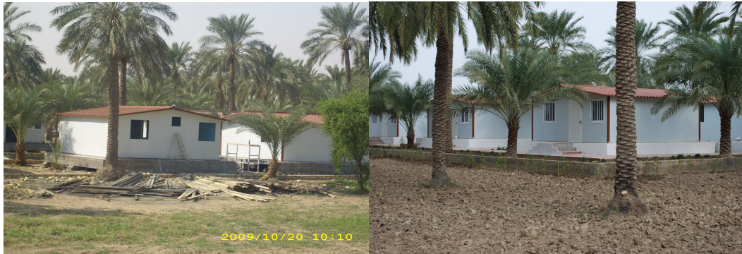
شكل رقم (٧): تركيب السندويج بنل في الجدران الداخلية والخارجية للبيوت
