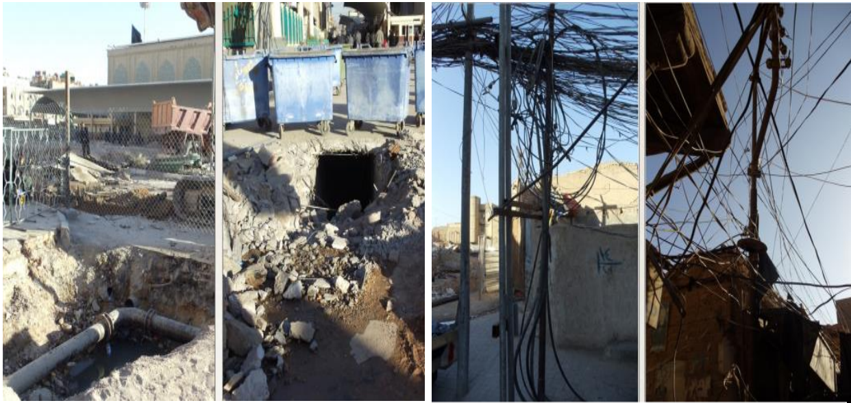
الشكل (9): يوضح تردي أوضاع الخدمات في محطة البراق، المصدر/(الباحثة)
