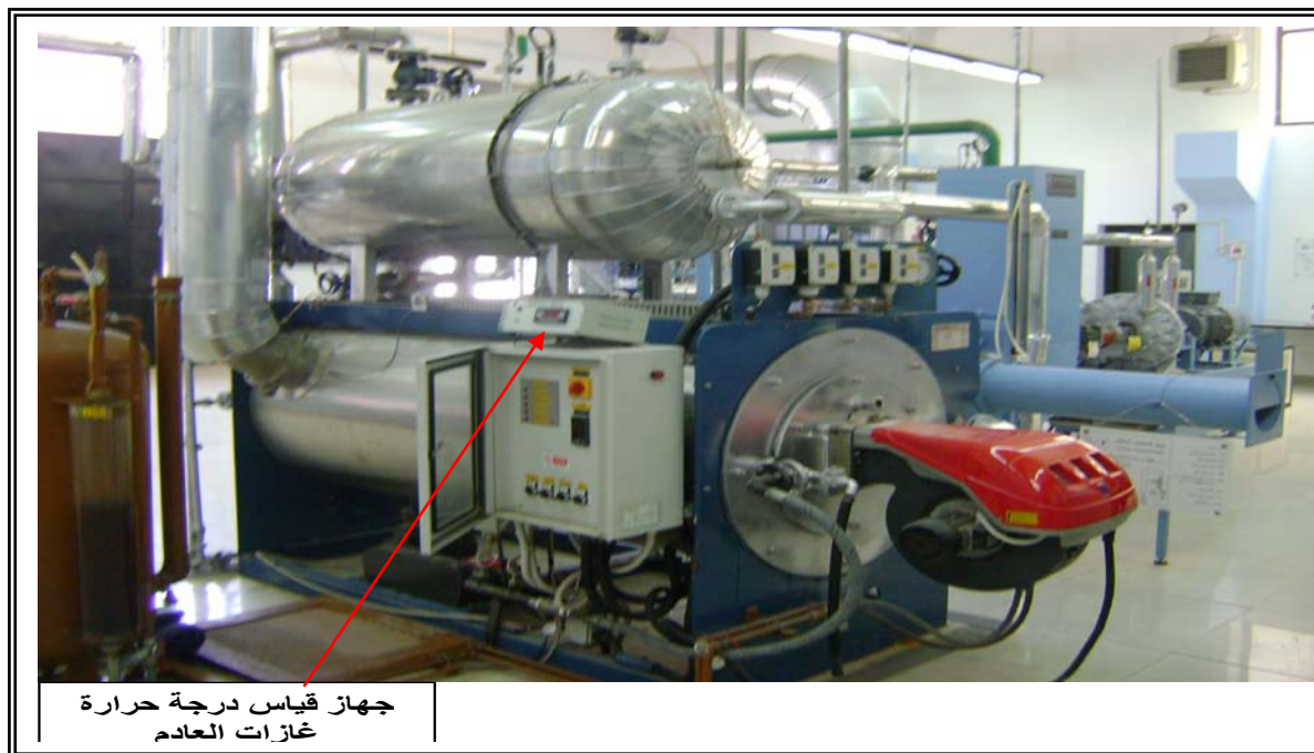
شكل رقم (3) صورة مولد البخار للمحطة البخارية ( Didacta Italia )
