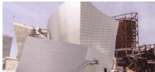
تركيب قطع الواجهات المصنعة رقما على السطح الخارجي لقاعة الحفلات p137 الموسيقية
