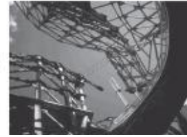
الهيكل الحديدي لمتحف كوكنهايم في بلباو -1997 نفذ ببرنامج (Bo-cad) p-159
