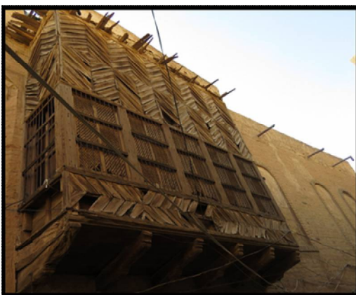
لوح ٣٠- شناشيل الجانب الجنوبي للواجهة الشرقية
