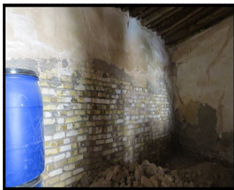
لوح-٤٨- اعادة بناء الجدار الغربي الارضي
