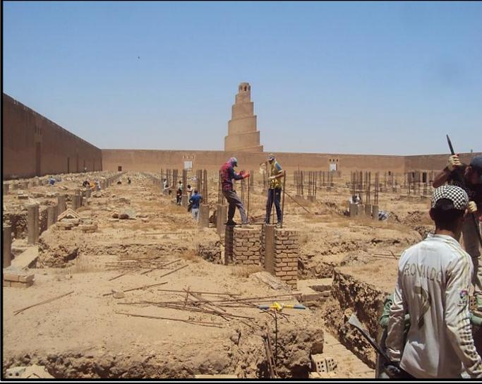
شكل (١٤) تبين عملية رالة الترميم الخاطئ التي حصلت في الجامع بفك اسياخ التسليح الموجود داخل صحن الجامع لشيف داؤة الاثار
