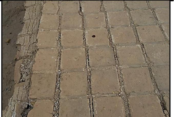
شكل رقم (١٥) تبين الترميم الخاطئ الحاصل في الارضية لشيف داؤة الاثار
