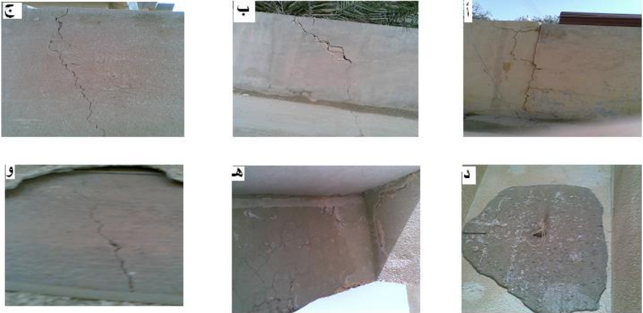
اللوحة ( ٢ ) ( أ ، ب ، ج ) تمثل تشقق الجدران الخارجية ، و تمثل ( د ، هـ ، و ) تشقق الجدران الداخلية و السقوف
