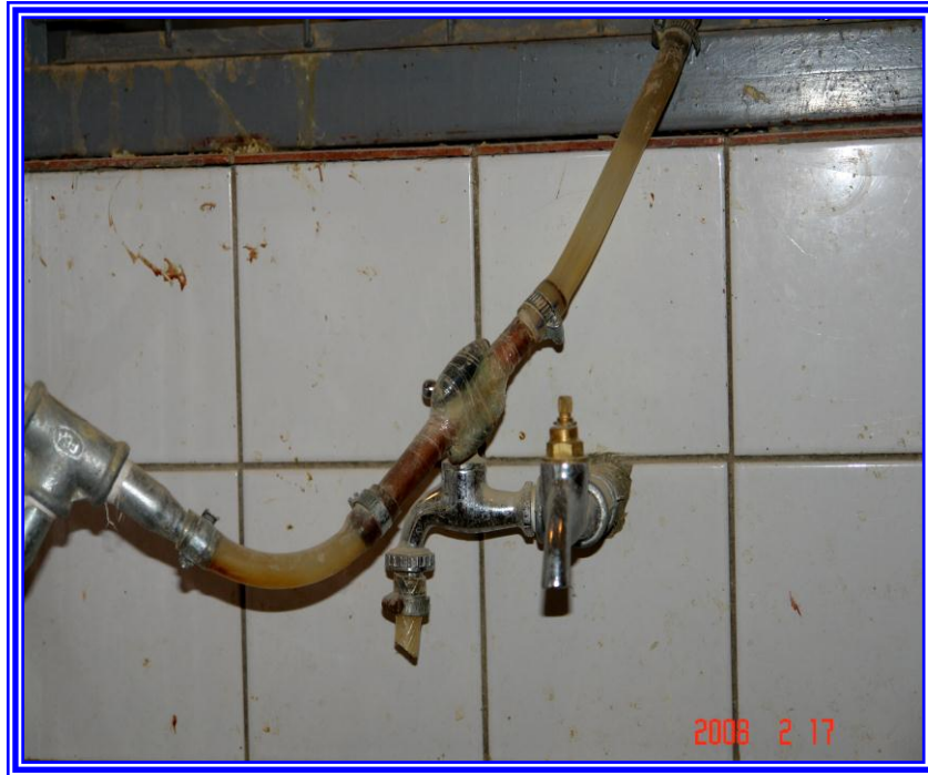
صورة (1) جهاز مغنطة الماء مربوط مع أنبوب تجهيز الماء
