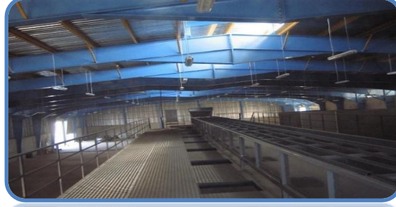
(صورة 1) سقف القاعة المكون من صفائح الحديد المغلون المعزول حرارياً، المصدر: الباحث
