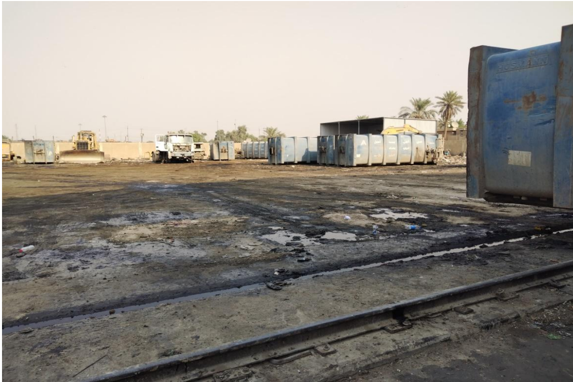
شكل (3) تغطية عصارة النفايات لأرضية المحطة التحويلية بالكامل المصدر : الباحثين الدراسة الميدانية ، 2022
