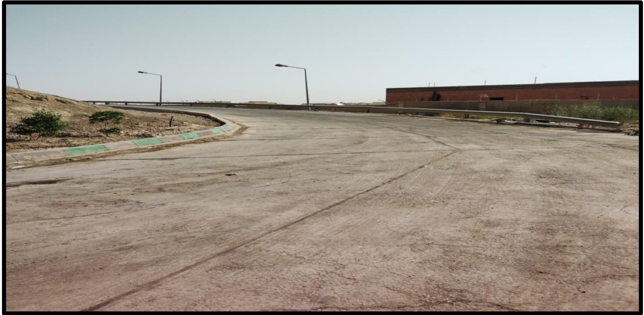
شكل (12، ب) تبليط ارضية المحطة بالخرسانة الصقلية وباستعمال الاسمنت المقاوم للأملاح المصدر : الباحثين الدراسة الميدانية ، 2022
