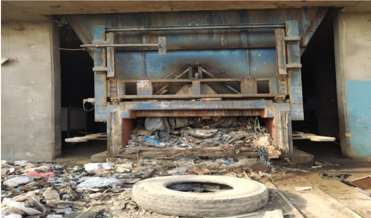
شكل (5) المكبس الثانوي ( الصغير) وهو ممتلئ بالنفايات لعدة ايام وانتشار النفايات حوله المصدر : الباحثين الدراسة الميدانية ، 2022
