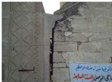
شكل 1: منطقة فصل قاعدة المنارة عن السياج الخارجي.
