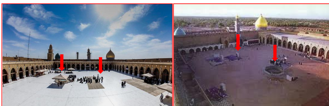
الشكل ( ٥ ) يوضح أرضية صحن المسجد التي كسيت بالمرمر الأبيض حيث كانت في السابق أرضية ترابية كما موضح وكذلك هو الحال بالنسبة لموضع المقامات والسفينة. المصدر / الباحث
