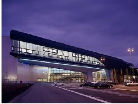
شكل(٧) مبنى بي أم دبليو BMW-لايبزك/ زها حديد
