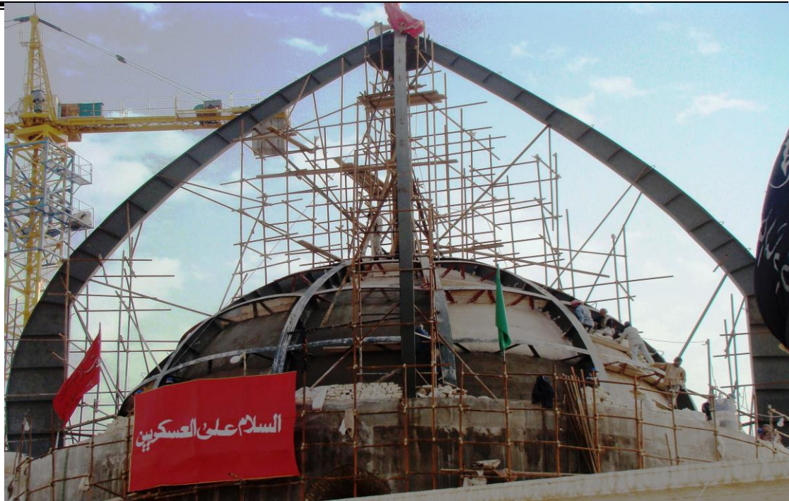
القبة اثناء وضع الهيكل الحديدي
