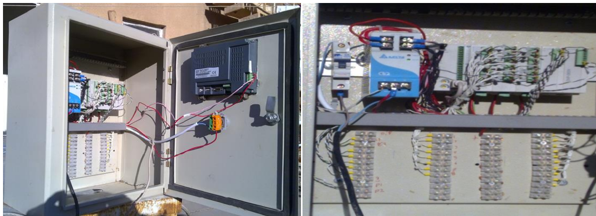
شكل (8): صور من الداخل للتحكم المنطقي المبرمج (PLC) المستخدم في المشروع البحثي
