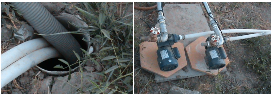
الشكل رقم (12): (أ): منظر امامي لمنظومة المضخات المستخدمة في البحث بينما يوضح الشكل (ب): فتحة البئر و انابيب السحب.
