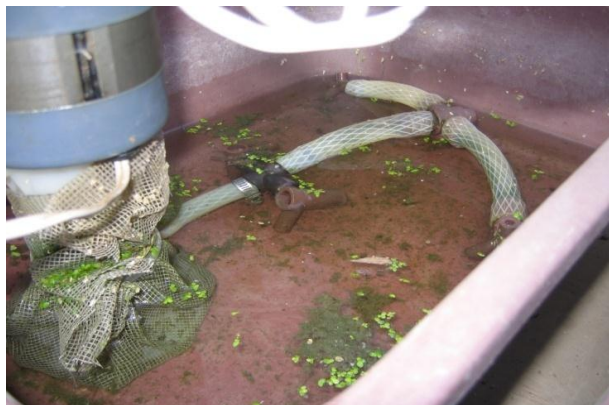
الشكل (2) آلية تحريك المياه مع المضخة ويظهر المشبك حول المحور الدوار للمضخة لحماية النبات من الانتقال خلاله.
