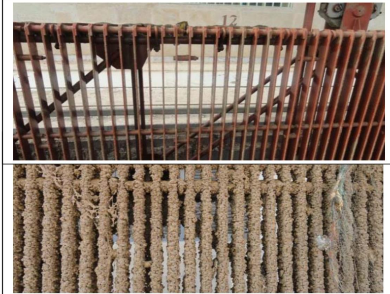
شكل 1-1: التصاق البرنقيل B.a.amphitrite على التراكيب السطحية في مأخذ مياه محطة توليد الطاقة الكهربائية.
