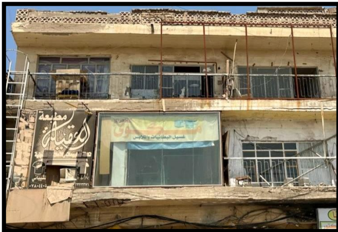
صورة (2) المباني القديمة في الكص الشمالي
