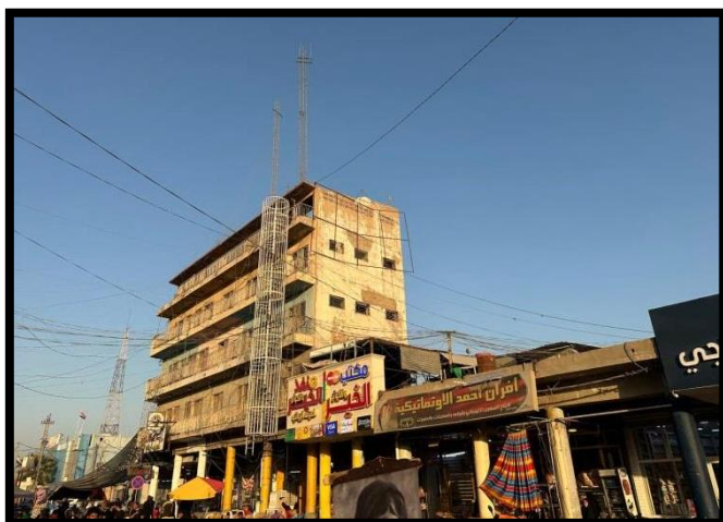
صورة (6) تباين ارتفاع البناء في الكص الجنوبي
