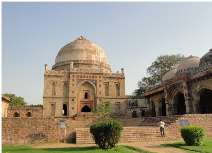
(شكل رقم ٥) قبة ضريح باراجومباد في دلهي (تصوير الباحث)
