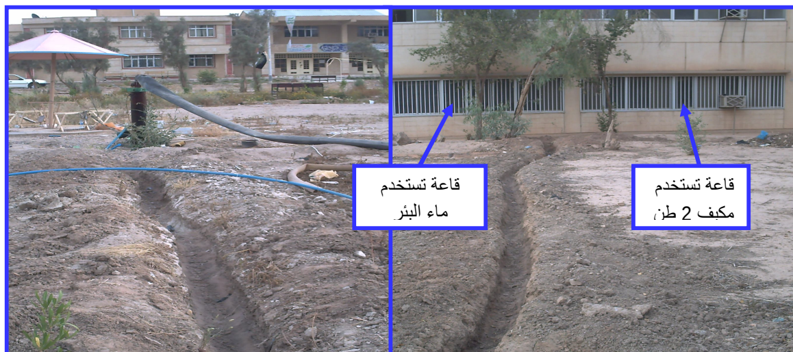
شكل رقم 5 يبين حفر خندق بعمق 70 سم لغرض مد الانابيب من البئر للقاعة.
