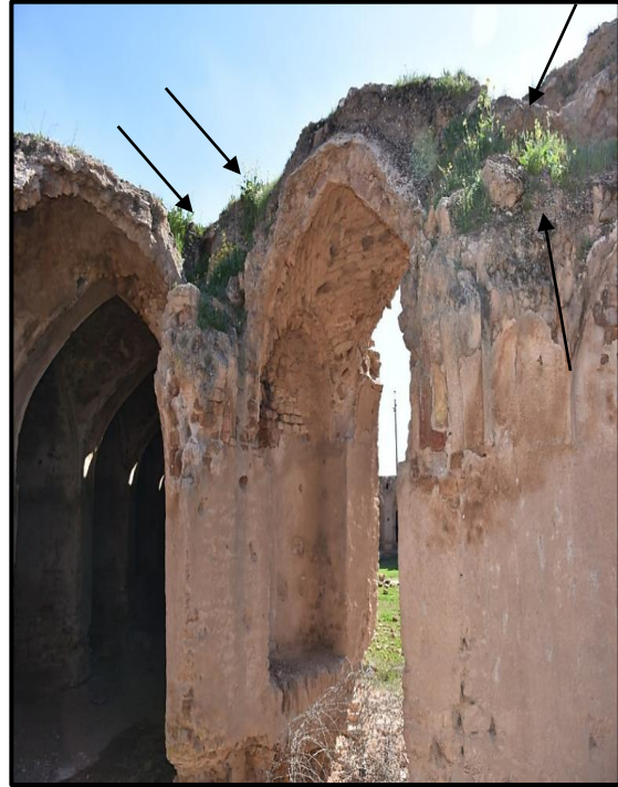
صورة رقم (١٨) تبين نمو النباتات في سقف الخان حيث تظهر نباتات كبيرة وصغيرة الحجم
