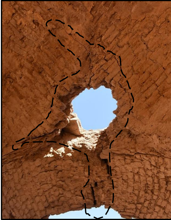
صورة رقم (١٩) تبين سقوط جزء من وجود العديد من الشروخ مختلفة الأحجام والشكل
