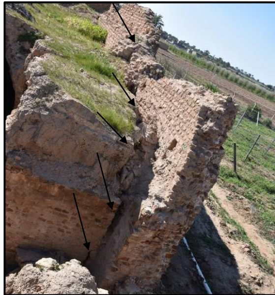
صورة رقم (١٦) تبين انفصال الجدار الخرجي عن الجدار الداخلي وحنوث ميلان في الجدار في
