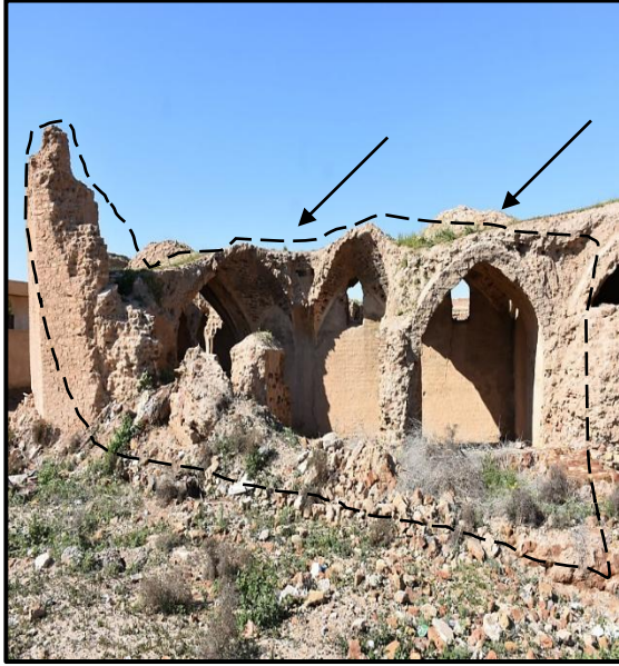
صورة رقم (١٥) تبين سقوط جزء من الجدار الخرجي وسقوط سقف القباب والعقود وتلف مواد
