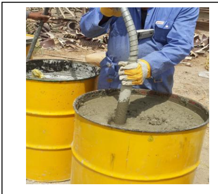
الشكل (٢) نقل النفايات داخل الكبسولة واطافة الخرسانة
