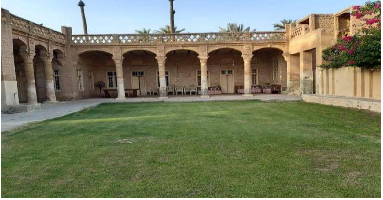
الصورة (٧) بيت قائمقام قضاء المسيب
