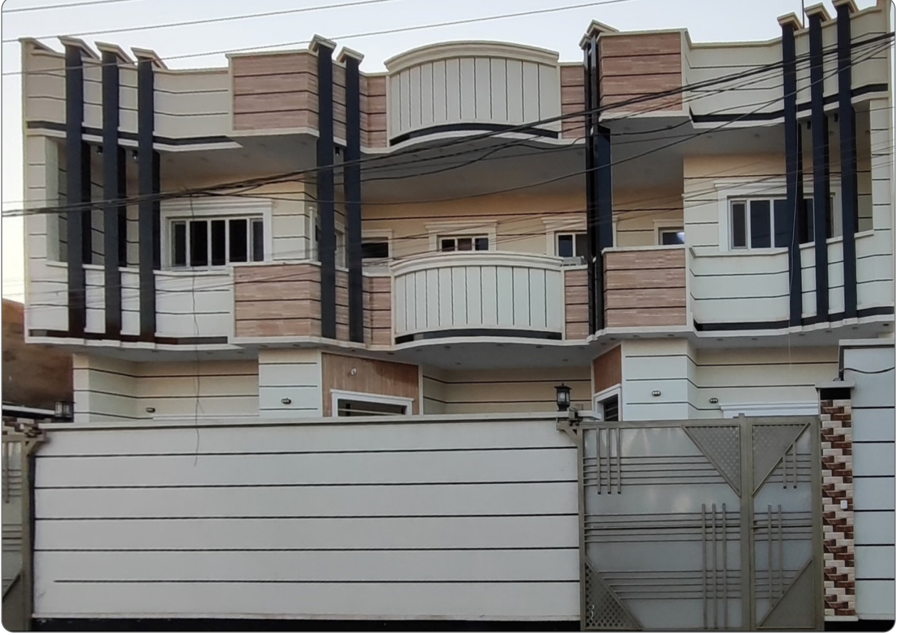
صورة (6) توضيح البيت ذو الطابقين الحديث
