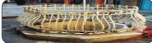
صورة رقم (٤٣-أ) حوض محفور بالأرض ويرتفع إطار من الحجر له شكل ثنائي ويعلو قضبان حديدية له شكل مقعر إلى الخارج ارتفاعه متر يأخذ شكل دائري فهي تعمل كدور حماية من السقوط.
