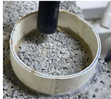
الشكل (١٩): استخدام المكنسة الكهربائية لشطف الغبار من المسامات
