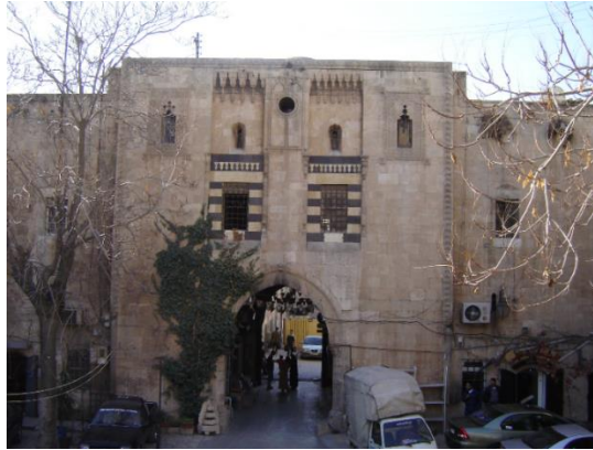
الصورة رقم (٤) توضح الواجهة الغربية الداخلية(الباحث)
