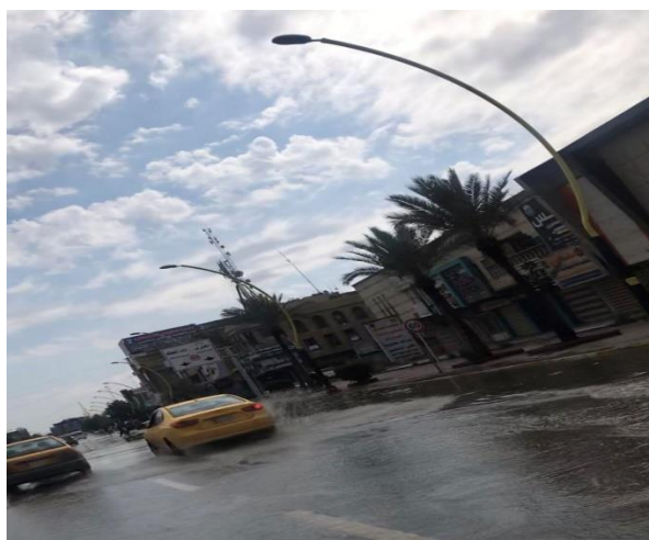
صورة (10) عدم كفاءة شبكات تصريف المياه في فصل الشتاء
