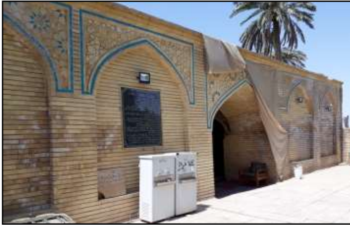
(الصورة - ٧) الواجهة الداخلية المطلة على الصحن
