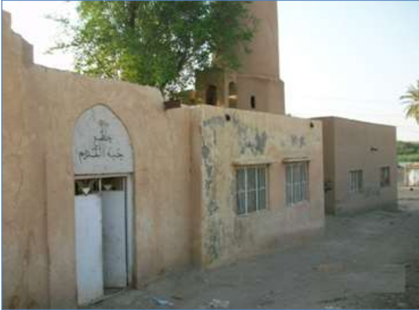
(الصورة - ٢) واجهة الجامع قبل التهديم
