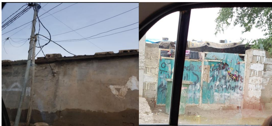
صورة (١١): بناء محل عشوائي داخل الوحدة السكنية
