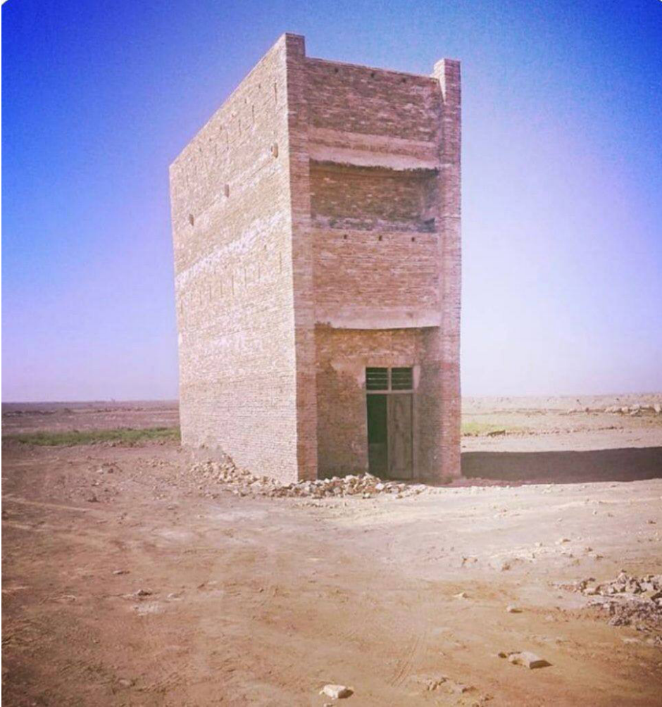
(١) الصورة بعدسة الباحث.
