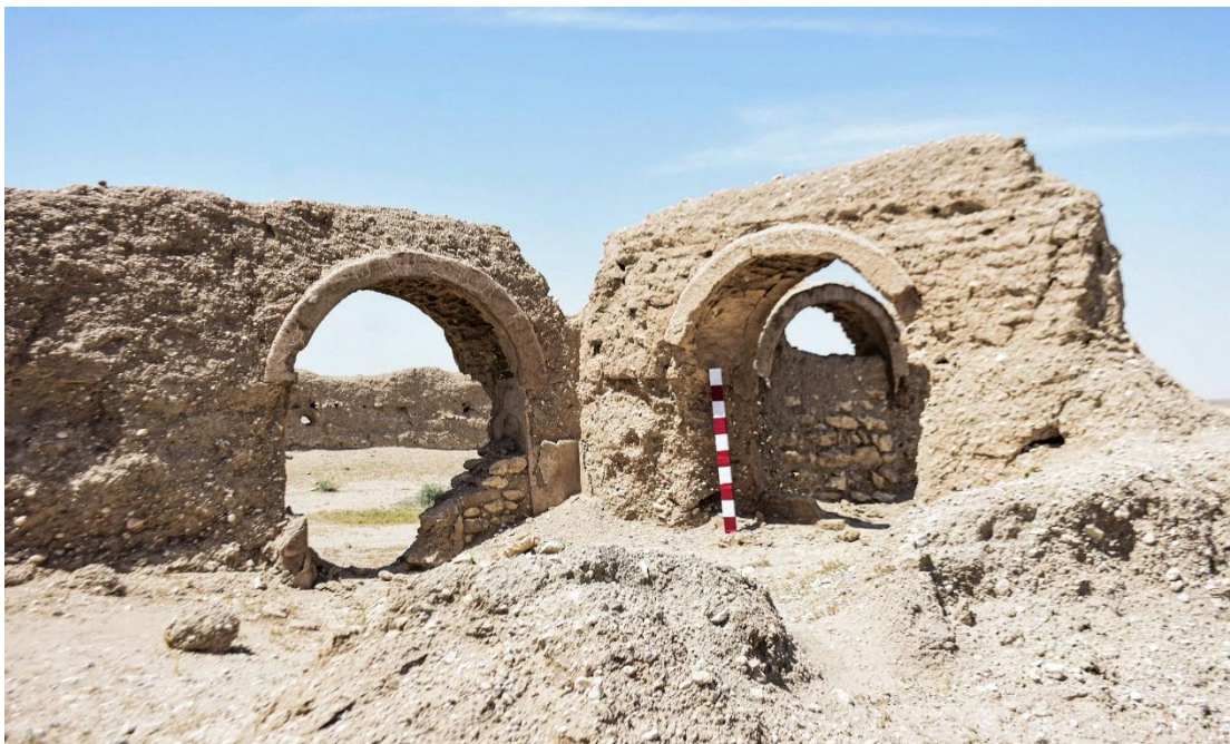
الشكل (3): تقوسات المداخل المعمولة بالأجر والجص في قلعة سعدون. (تصوير الباحث)
