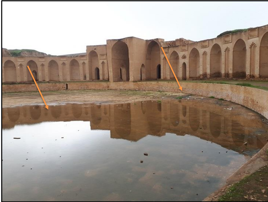
صوره رقم (9) تبين تجمع مياه الامطار داخل الحوض الدائري الموجود مما يؤثر على اوان المبنى
