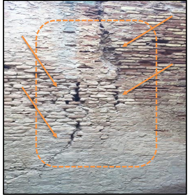
صوره رقم (12) تبين وجود شروخ وانبعاج في الجوانب الداخلية للحمام تنتجها مياه الأمطار والضربة
