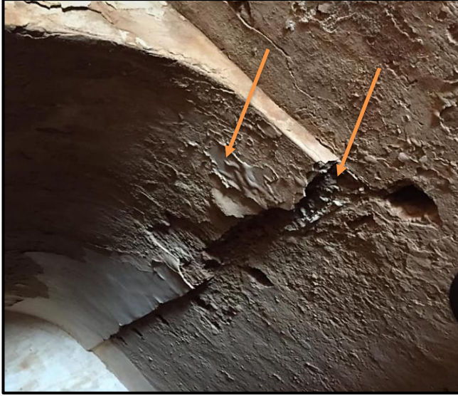
صوره رقم (3) تبين ارتفاع الرطوبة داخل الجوان الداخلية لحمام الوكة بفعل المياه الأرضية وتآكل مواد البناء
