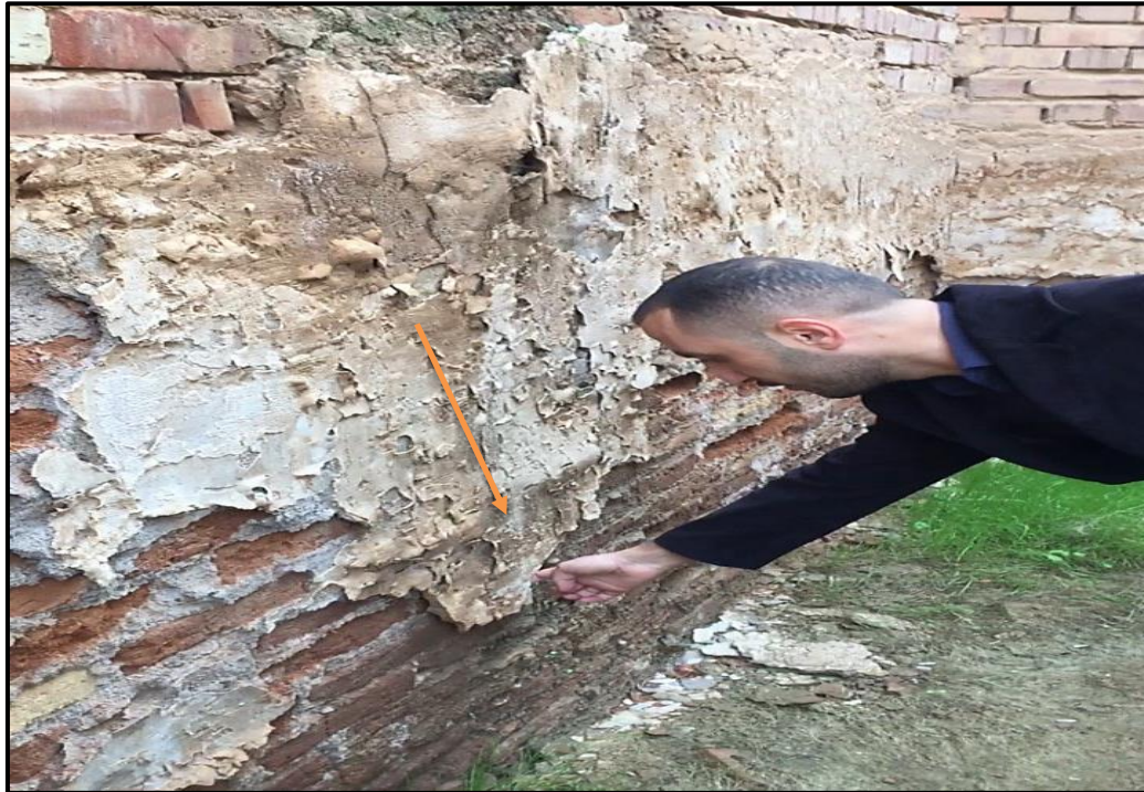
صوره رقم (10) حيث تظهر تأثير مياه الامطار وتسبب في سقوط طبقة الملاط وضعف مواد البناء
