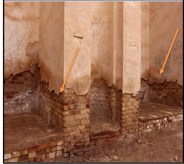
صوره رقم (4) تبين تآكل أساسات الحنايا والعقود لحمام الوكة بفعل المياه الأرضية وسقوط طبقات
