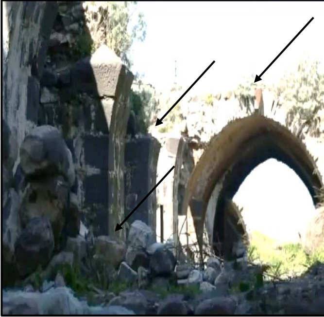
صورة رقم (١١) تبين سقوط أجزاء من الجوانب في أحدى ممرات القلعة
