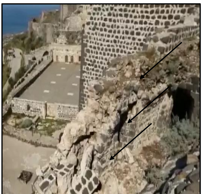
صورة رقم (١٤) تبين سقوط أجزاء من الجوانب في أحدى الأجزاء العلية من القلعة
