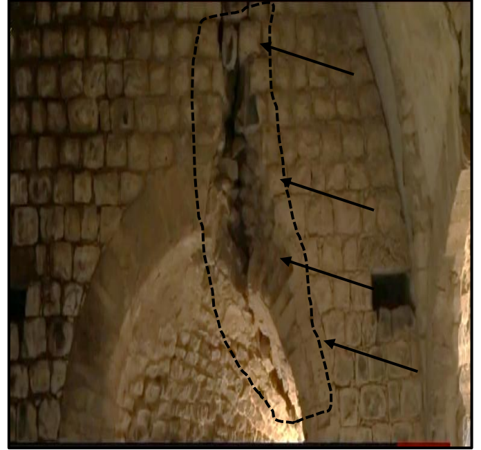
صورة رقم (١٢) تبين شروخ كبيرة الحجم في الجزء العالي من القلعة
