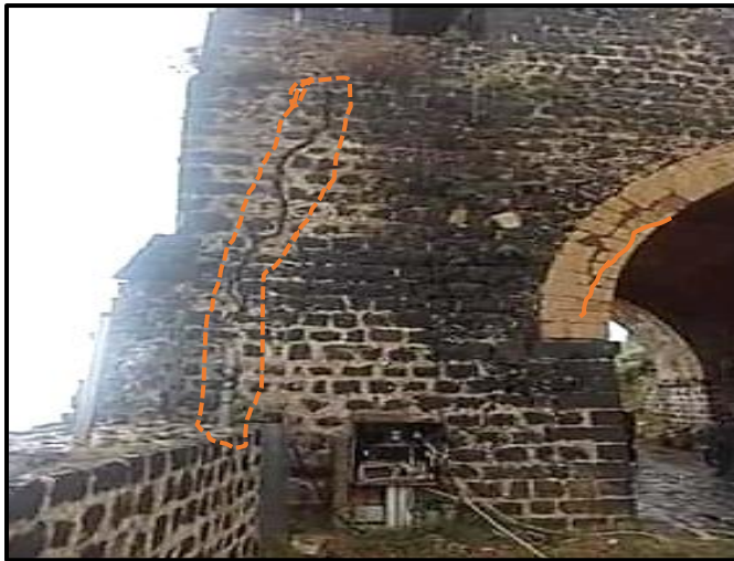
صورة رقم (٧) تبين وجود العديد من الشقوق في الأجزاء العلوية من القلعة
