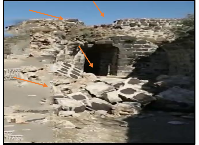
صورة رقم (٦) تبين سقوط مواد البناء للقلعة وتظهر سقوط
